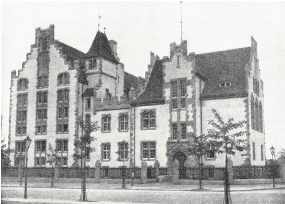
Neubau des damaligen Staatsarchivs Magdeburg an der Augustastraße, in: Zentralblatt der Bauverwaltung Nr. 92 (1909), S. 599
